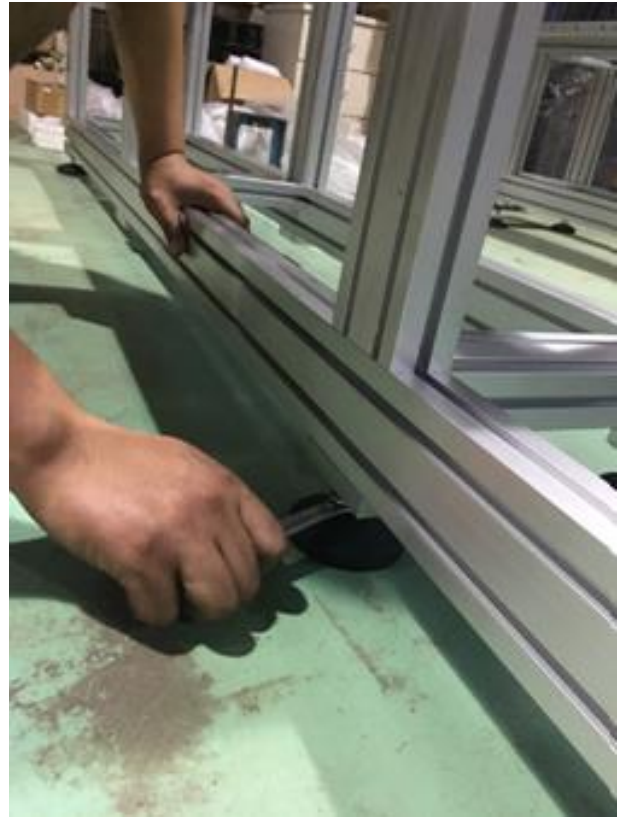
Рис.9 Регулировка уровня стоек.
