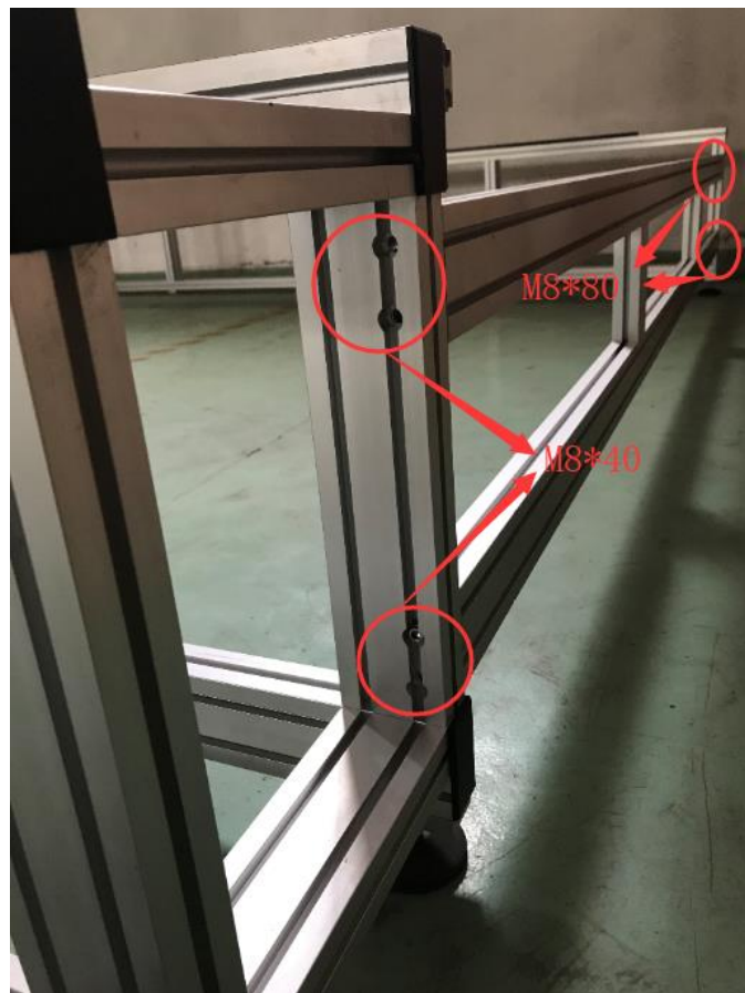
Рис.10 Установка поперечной балки
